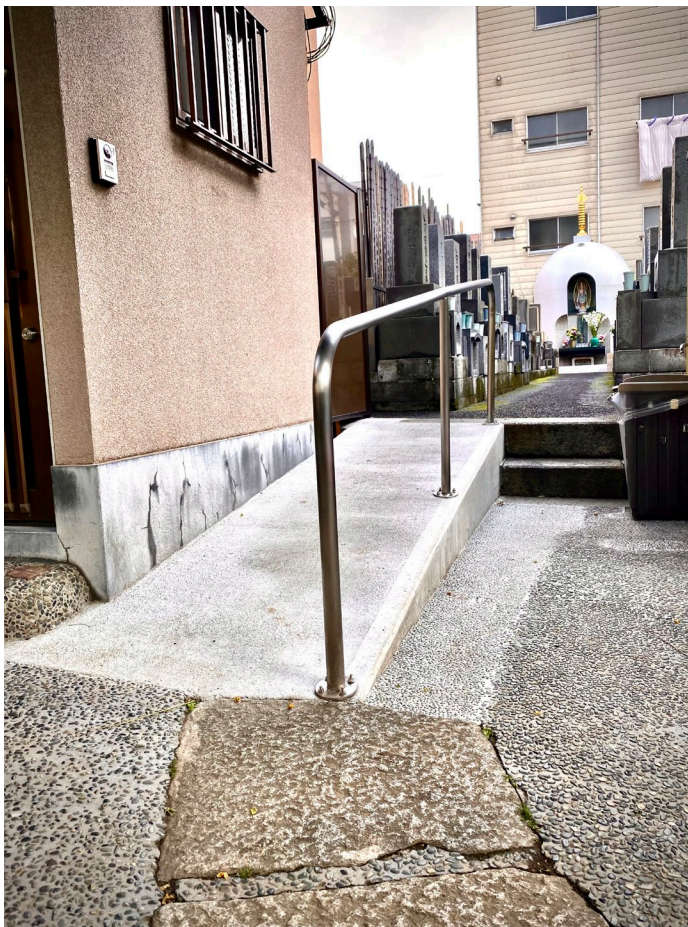
完成した光照院墓地のスロープ
