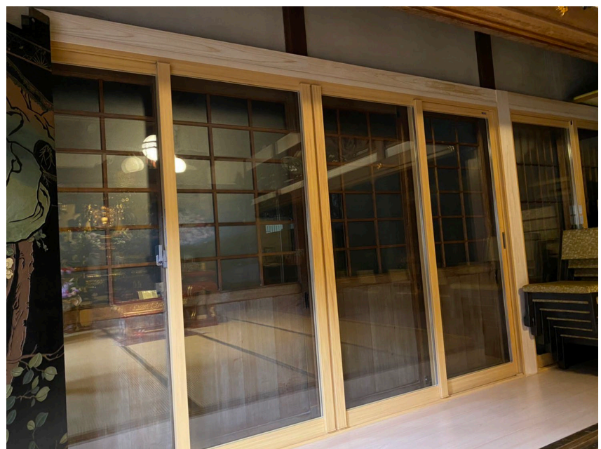
本堂に断熱防音の二重サッシがはいました！
